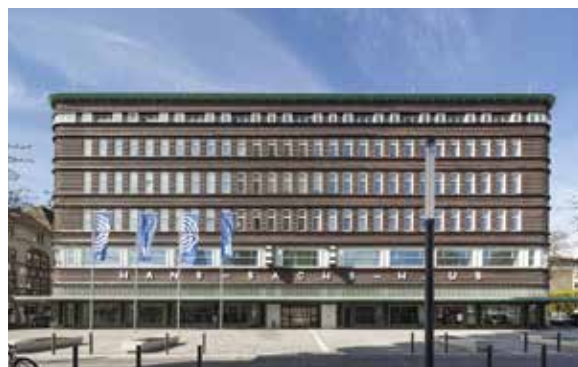
Eines der BÜRGERCenter befindet sich im Hans-Sachs-Haus.
